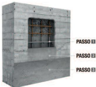
**1 - TRATAMENTO DE ELEMENTOS METÁLICOS** - quando a durabilidade do betão é comprometida pela corrosão metálica, este deixará de cumprir a sua função de proteção de armaduras.
