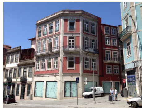
Prédio Granito Cinza Micaela Buj. Rua Damião de Góis, Porto
