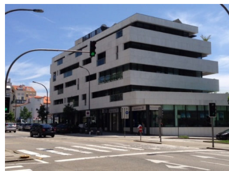
Prédio Mármore Branco Angola Rua Damião de Góis - Porto
